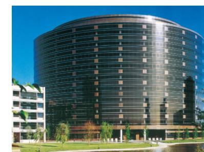
ハットン・センタービル
