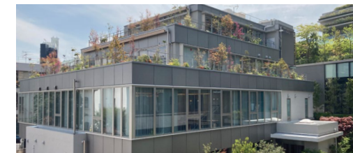
プレファス原宿 (第10 荒井ビル)
