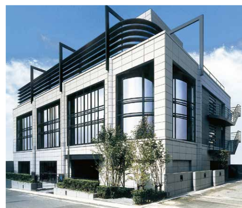
新第3荒井ビル(南平台)
